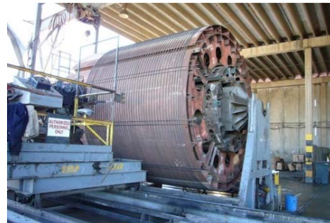
Fig. 1-7. Mandrel wire cage fabrication.
